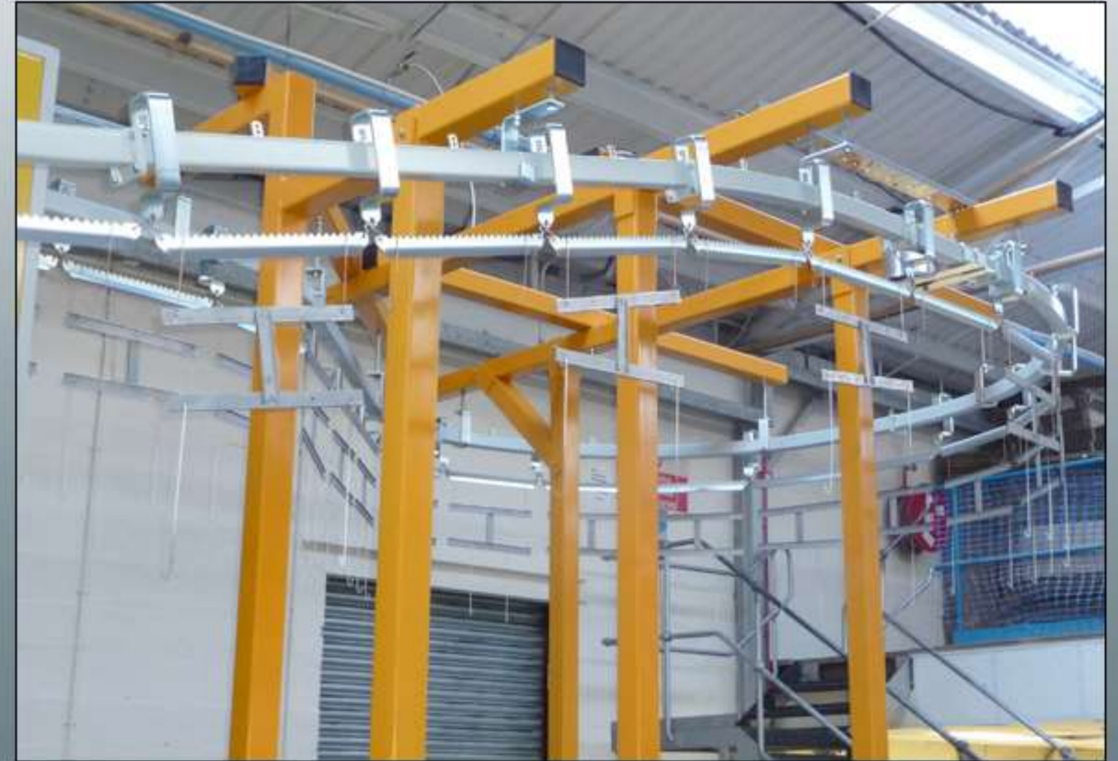
Kreisförderer - C•Haken im Einsatz
